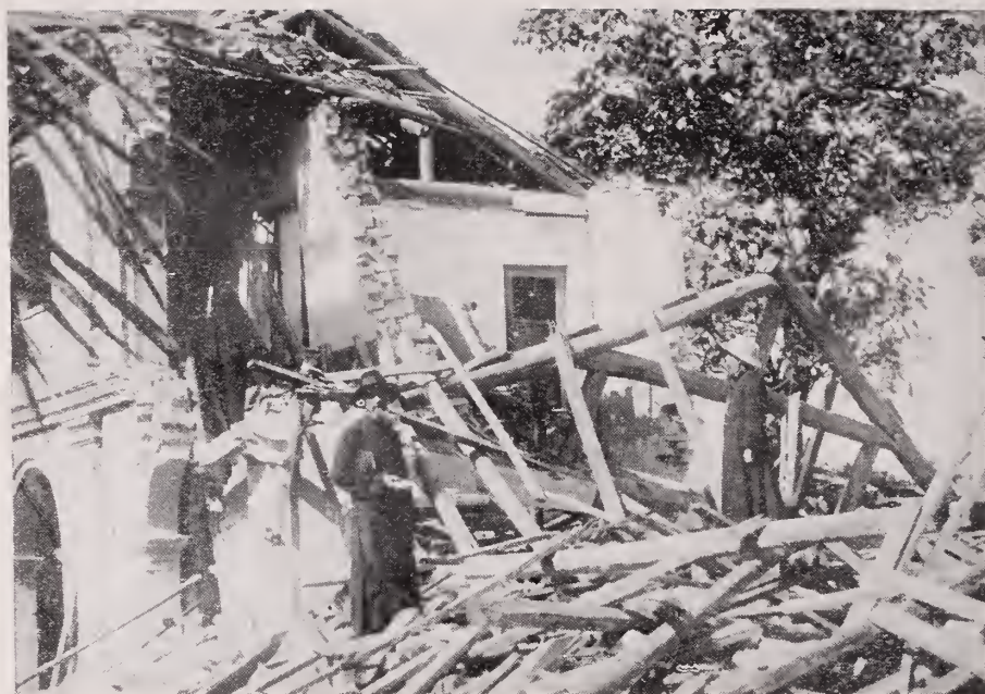
Estos son restos de lo que fué Catedral, Hospital Católico, Casa Parroquial y Residencia del Vicario Apostólico de la Misión de Laohokow, Hupeh, China, confiado a los PP. Franciscanos. Los bombardeos han sembrado de escombros la población.
